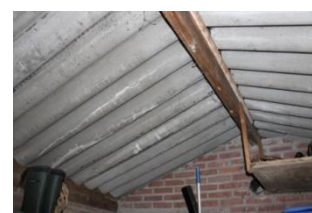
Asbest golfplaten berging
