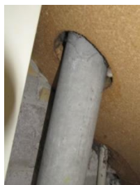
Asbest ventilatiekanaal
